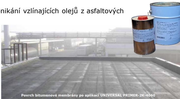
Povrch bitumenové membrány po aplikaci UNIVERSAL PRIMER-2K-4060
